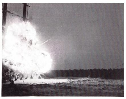
Abb 2: Auftreffer der ADATS-Lenkwaffe auf Kampfpanzer (Schiesserprobung)
