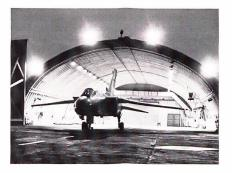
und Bewaffnungseinrichtungen. Bypass-Entlüfter gestatten es, die Flugzeuge im Innern des Unterstands anzulassen, während das Tor geschlossen ist. Nach einem feindlichen Angriff dauert es nur wenige Minuten, die beiden 800-Tonnen-Torhälften aus mit Stahl verstärktem Beton zu öffnen und zum Gegenangriff überzugehen. Nach der Rückkehr können die Flugzeuge schnell wieder in die Unterstände eingefahren werden, so dass sie bis zu ihrem nächsten Einsatz vollständig geschützt sind.
