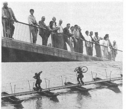
Von der Brücke herab beobachteten die Grossrätinnen und Grossräte den schnellen Einbau des Steg 58 über die Reuss mit nachfolgender Übersetzaktion.
