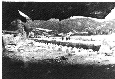
Blick aus einem griechischen Bunker, davor Betonhöcker, in Angriffsrichtung 1./125. Rechts die Struma
