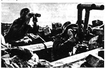
Bild aus dem Zweiten Weltkrieg: Deutsche Artilleriebeobachtungsstelle. Ein Schiesskommandantentrupp an der Arbeit: Im Vordergrund: Beobachter am Scherenfernrohr. Beachte das rechteckige Deckungsloch. Mit Kantholz verstärkt.
