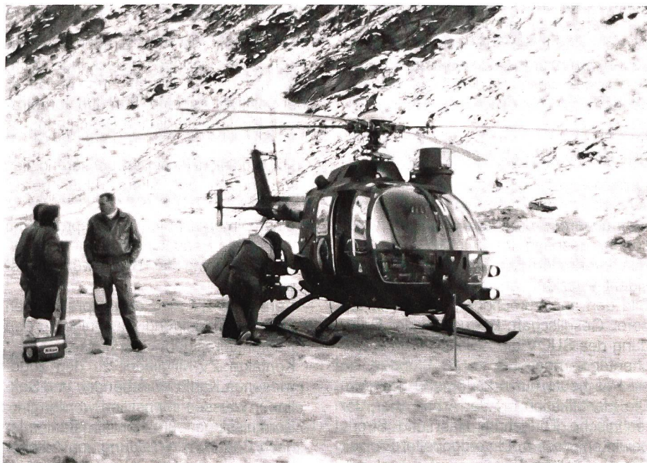
Der Panzerabwehrhelikopter BO-105 CB der Firma Messerschmitt-Bölkow-Blohm (MBB) in Hinterrhein. An seitlichen Abschussvorrichtungen kann er 8 Lenk Waffen des Typs «TOW» mitführen. Der Aufbau über der linken Seite der Kabine stellt die optische Zielvorrichtung dar. WSCHM
