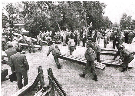
Junge Tessiner Wehrmänner demonstrieren den interessierten Veteranen den schulmässigen Einbau der «Festen Brücke 69» über einen Nebenarm der Aare.
