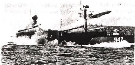
Sowjetisches Raketschnellboot startet einen der vier Flugkörper, die in abgerundeten Containern untergebracht sind, die auch gleichzeitig die Startanlagen bilden. Ein unter dem Heck befestigtes Starttriebwerk bewegt den Flugkörper der Klasse Schiff-Schiff von der Startschiene, während das im Rumpf unterge-
