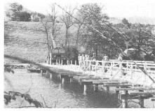
Ende Monat Mai und anfangs Juni begannen Wehrmänner der Stabs-Kp des Genie-Rgt 6 mit der Errichtung der Brückenpfeiler für diese Fussgängerbrücke. Am Oberbau beteiligten sich verschiedene Kompanien der Genie-RS 67. Die Brücke misst in der Breite 4 Meter und hat eine Länge von 98,5 Meter und kann mit 18 Tonnen belastet werden. Dieser Übergang ist mit einem Fahrverbot belegt, weist aber – wie Beobachtungen gezeigt haben – eine
