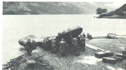
Was so stürmisch endete, begann recht friedlich: Bau der Schlauchbootfähre bei Brunnen.
