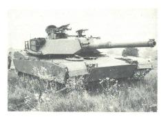
Der M 1 Abrams auf Fahrparcours. Die starke Turbine jagt den Kampfwagen mit maximal 72 km/h über die Strasse oder mit nahezu 54 km/h durch das Gelände
