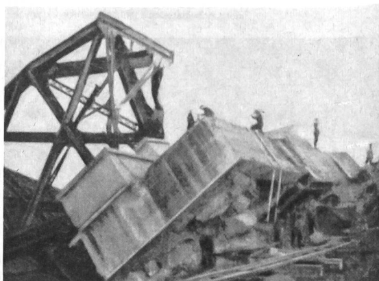
Das zerstörte Widerlager auf dem Liessauer-Ufer
