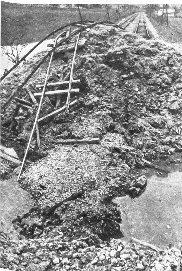
Der von Fliegerbomben getroffene Bahnkörper.
