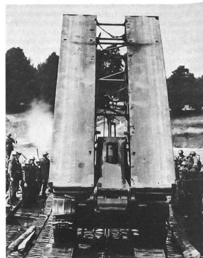
Die Nationale Volksarmee der DDR verfügt über moderne Brückenlegepanzer des Typs BLG-60, die – nach Ansichten von DDR-Militärfachleuten – eine «Spitzenstellung» hinsichtlich ähnlicher Konstruktionen der NATO-Armee einnehmen. Die Scherenbrücke kann in kürzester Zeit abgelegt werden. Die Sturmbrücke ist variabel einsetzbar und entspricht modernsten Ansprüchen.
