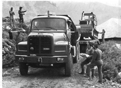
Überschwerer Saurer-Muldenkipper für die Genietruppen der Schweizer Armee. Dieselmotor 243 kW (330 PS), Gesamtgewicht 25 t, Antrieb 6×4.
