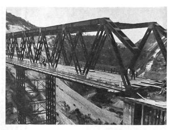
Von den Pionieren eingebaute Kriegsbrücke. Tragkraft über 50 Tonnen
