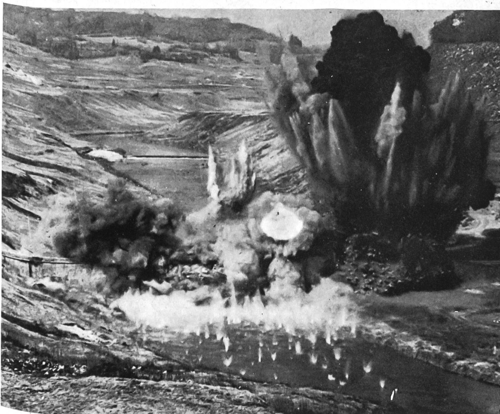
Sprengung eines Überganges
