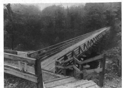
Eine saubere, sinnvolle WK-Arbeit: Der 95 m lange und 4,4 m breite Fussgängersteg über die Reuss, im sogenannten Dominiloch, wenig oberhalb vom Frauenkloster Hermetschwil.
