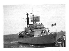
Der neue Raketenzerstörer «HMS Birmingham» folgte an der Flottenparade der königlichen Jacht «Britannia». Vorne sind die 11,4-cm-Kanone und der Zwillingsstarter für die See-Luft-Flugkörper des Typs Sea Dart zu erkennen. Auf diesem Schiff fuhr die versammelte Admiralität mit. Es fungierte als Flaggschiff der Parade.
