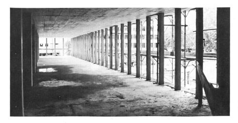
Innenansicht eines Bürogeschosses im Rohbau mit vorfabrizierten Stützen.
