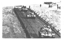
TPP-Brückengerät (Tjasholij Pontonnij Schwere Brückenpark), aus einem Satz TPP kann eine etwa 150 m lange Brücke der Lastenklasse 50 gebaut werden. Zum Transport dieses Gerätes sind allein 62 Pental KW einfarfallich sind allein 62 Ponton-LKW erforderlich. Meistens wird die Brücke von Motorbooten im Strom gehalten, es besteht jedoch auch die Möglichkeit der Verankerung (Strom-, Wind- und Seilverankerung). Die Bauzeit (bei grossem Truppeneinsatz) beträgt etwa 30 Minuten.
