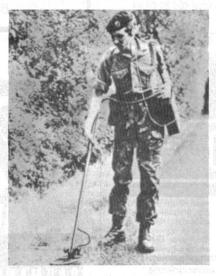
In allen NATO-Streitkräften ist eine Vielzahl von Minensuchgeräten vorhanden. Die meisten sind amerikanischer Herkunft. Die älteren Geräte sprechen auf Metall an, dieser Baustoff wird jedoch nur noch selten bei der Konstruktion von Minen verwendet Neuere Geräte, wie das An/PRS-7, sprechen auf metallische und nichtmetallische Panzer- und Schützenminen an.
