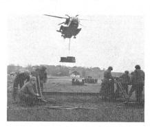
Während der schwere Sikorsky-Hubschrauber noch eine Palette mit Teilen des «Brückensystems 75» bringt, haben im Vordergrund bereits die Pioniere mit dem Zusammenbau begonnen. Die fertige Brücke wird dann über den Fluss geschoben.
