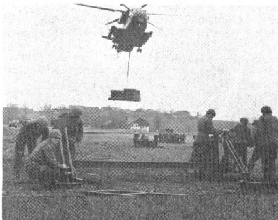
Während der schwere Sikorsky-Hubschrauber noch eine Palette mit Teilen des «Brückensystem 75» bringt, haben im Vordergrund bereits die Pioniere mit dem Zusammenbau begonnen. Die fertige Brücke wird dann über den Fluss geschoben.
