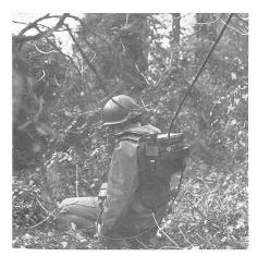
Amecom, eine Tochtergesellschaft der Litton Industries, erhielt von der amerikanischen Armee einen Auftrag zur Herstellung von Loran-Ortsbestimmungsempfängern. Die Empfänger sind so klein, dass sie von den Soldaten auf dem Rücken getragen werden können. Unter dem 5 160 000-Dollar-Auftrag wird Amecom 118 Loran-Empfänger (AN-PSN-6) sowie 79 Adapter zur Befestigung der Geräte auf Lastkraftwagen oder gepanzerten Personentransportern liefern.
