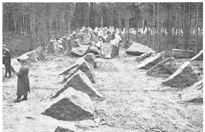
Mannerheimlinie. Finnisches Panzerhindernis aus Granitblöcken.
