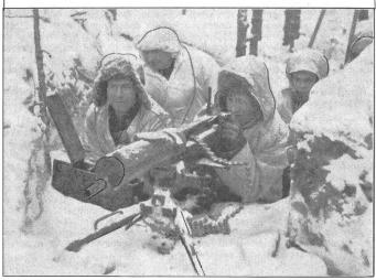
Bild oben: Finnisches Maschinengewehr, System Maxim. Gewicht: Gewehr 23 kg, Lafette 25 kg. Wassergekühlt, Kadenz 500 Schuss/Minute, Vo 800 m je Sekunde, Hanf- oder Metallgurten zu 250 Patronen. Der gleiche Maschi-nengewehrtyp wurde während des Zweiten Weltkrieges in der Schweizer Armee unter dem Namen Mg 11 verwendet.
