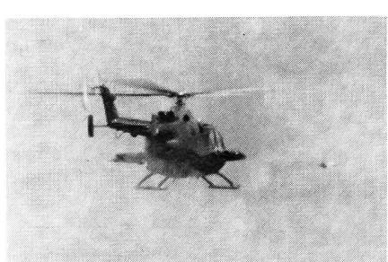
Abschuss einer schweren drahtgesteuerten HOT-Panzerabwehrkanone der zweiten Generation ab einem leichten Mehrzweckhubschrauber BO-105. Bei einer Vorwärtsgeschwindigkeit des Trägerflugzeugs von wenigstens 180 km/h erreicht der HOT-Flugkörper eine Reichweite von 4400 m. Die 22 kg schwere Lenkwanne besitzt einen 6 kg schweren Hohlladungsgefechtskopf, der alle bekannten Fahrzeugpanzerungen glatt durchschlägt.
