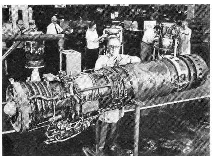
Mit dem Tiger erhält unsere Flugwaffe erstmals ein zweistrahliges Kampfflugzeug. Bei den eingebauten Triebwerken handelt es sich um Strahlturbinen des Typs J85-21, die seit rund vier Jahren bei der Firma General Electric in Lynn, Massachusetts, hergestellt werden. Die 21iger Version der seit rund 20 Jahren in der Reihenfertigung stehenden J85-Familie besitzt einen neunstufigen
