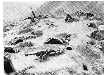
Foto H: Bau einer Feuerunterstützungsbasis
