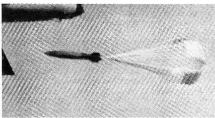
Eine Speialeinrichtung verhindert die Detonation nach der Erderührung, falls sich das Trägerflugzeug nicht ausserhalb der splittergefährdeten Zone befindet. Die Abwurfwaffe wird in einem solchen Falle mit einer Verzögerung von 15 Sekunden durch den zum System gehörenden Zeitzünder zur Explosion gebracht. Unsere folgende Dreiseitenansicht zeigt eine mit der Matra Bremsschirmvorrichtung ausgerüstete einsatzbereite 400 kg Tiefangriffsbombe. (ADLG 5/75) ka
