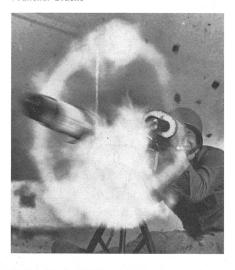
Eine drahtgelenkte Panzerabwehrrakete im Augenblick des Abschusses. Mit dieser Rakete können auf eine Distanz von 1000 m feste und bewegliche Ziele bekämpft werden. Das Geschoss durchschlägt den Panzer aller bekannten Kampffahrzeuge.
