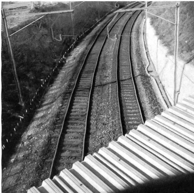
Erstes Panzerhindernis, linker Teil: Eisenbahneinschnitt mit Wirkung eines Panzergrabens. Länge des Panzergrabens: 400 m. Standort des Photographen: bei der gesprengten Strassenbrücke.
