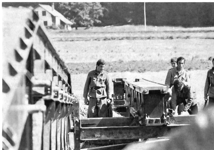
Der Vorbauschnabel wird am gegenüberliegenden Ufer abgebaut.
