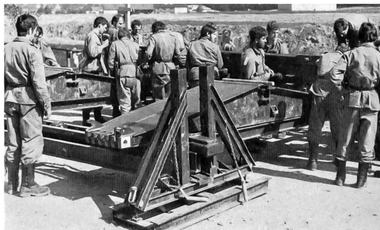
Montage des Uferbalkens auf die Auflagerdreiecke
