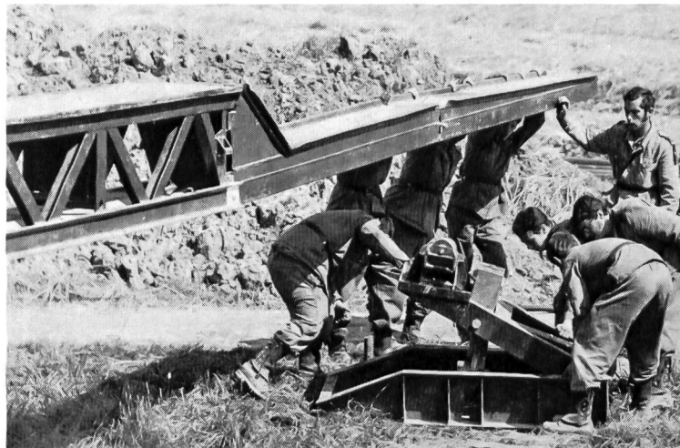
Das Auflaufrollenlager wird unter dem Schnabel bereitgestellt.
