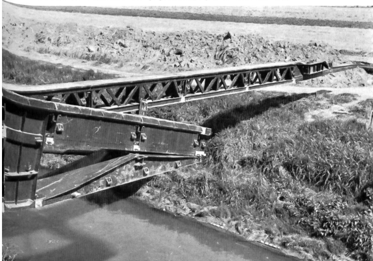
. . . bis der Schnabel das gegenüberliegende Ufer erreicht.
