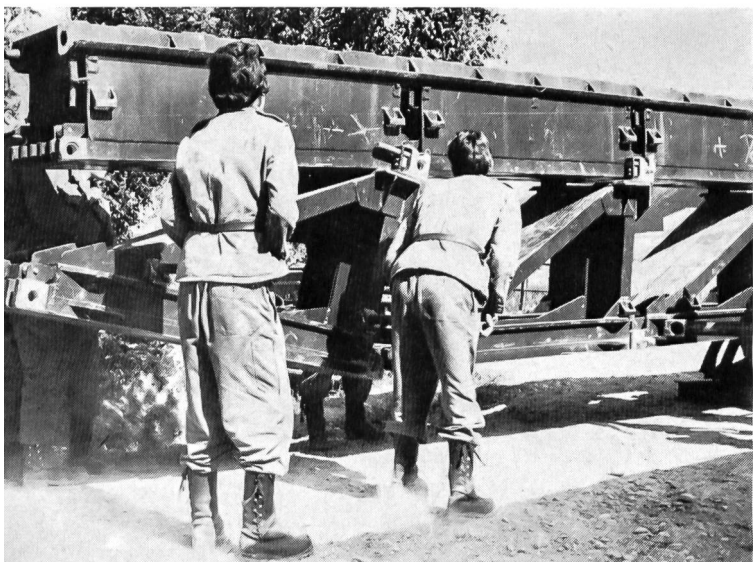
Einbau eines Fachwerkelementes
