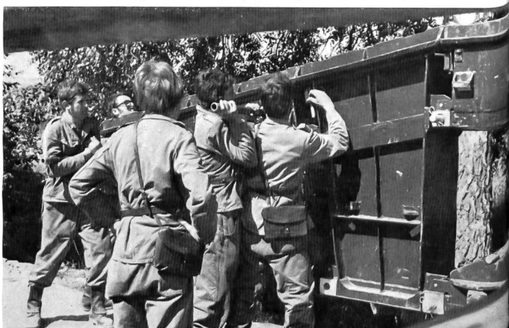
Brückenende: Die Rampe am Einbauufer wird angeschlossen.
