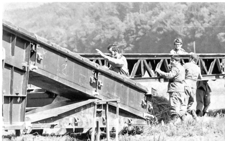
Die Brücke befindet sich am gegenüberliegenden Ufer. Der Schnabel wird abgebaut.
