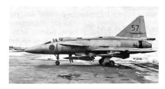
Die RB-05 ist eine Luft-Boden-Lenkwaffe, die für die Bekämpfung von Land- und Seezielen vorgesehen ist. Unter gewissen Umständen kann sie auch für die Zerstörung von Luftzielen verwendet werden. Unsere Aufnahme zeigt eine AJ 37 bestückt mit vier dieser 305 kg schweren und von einem rauchfreien Volvo-Flygmotor Flüssigkeitsraketenmotor angetriebenen Flugkörper. Funksteuerung, optische Verfolgung. Länge 3,6 m, Durchmesser 0,3 m, Spannweite 0,8 m.
