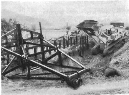
Die Entfernung der bis zu drei Meter hohen Eisenbahnschienen, die bis zu zwei Meter tief in den Boden eingerammt wurden, ist in einzelnen Abschnitten, je nach Festigkeit der Unterlage, nicht leicht. Ein schwerer Trax lockert sie durch seitliche Stöße und zieht sie mit einer Kette aus dem Boden. Im Vordergrund eine mobile Sperre, durch die einzelne Zufahrtswege im Abwehrgebiet offen gehalten werden konnten. RIA
