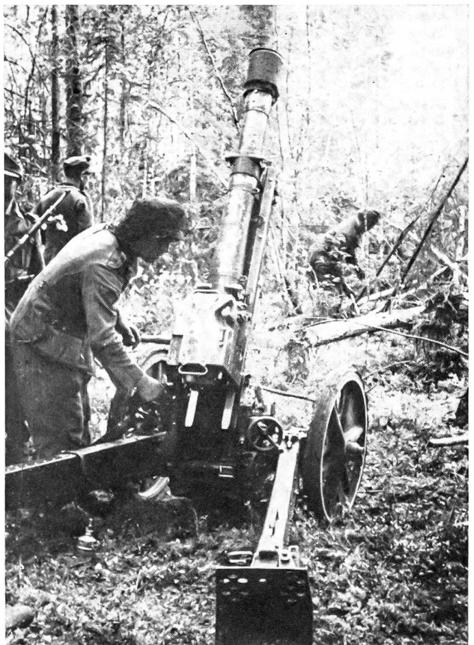
Deutsche 7,5-cm-Gebirgskanone in Feuerstellung in einem Bergwald. Beachte: Kein Schutzschild, kleine Räder, Möglichkeit für grosse Rohrerhöhung.
