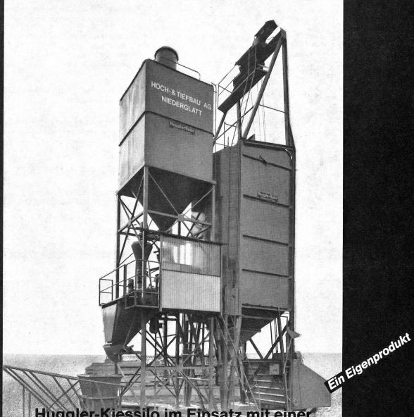
Huggler-Kiessilo im Einsatz mit einer Zwangsmischeranlage Huggler
