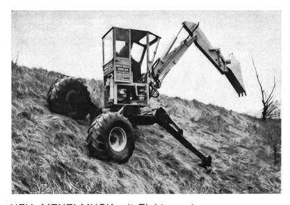
Der Bagger, der mehr leistet als die anderen, weil er nicht nur für die üblichen Baggerarbeiten eingesetzt werden kann, sondern auch im Steilhang und im Sumpf, wo bisher nur Handarbeit möglich war. Der MUCK hilft Arbeitskräfte sparen und Unkosten senken.
