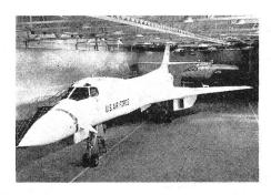
ablösen. Das abgebildete Mock-up ist aus Aluminium, Stahl und Holz hergestellt. Seine Vollendung bedeutet einen wichtigen Schritt im Rahmen eines jeden Flugzeugbauprogrammes. ka
