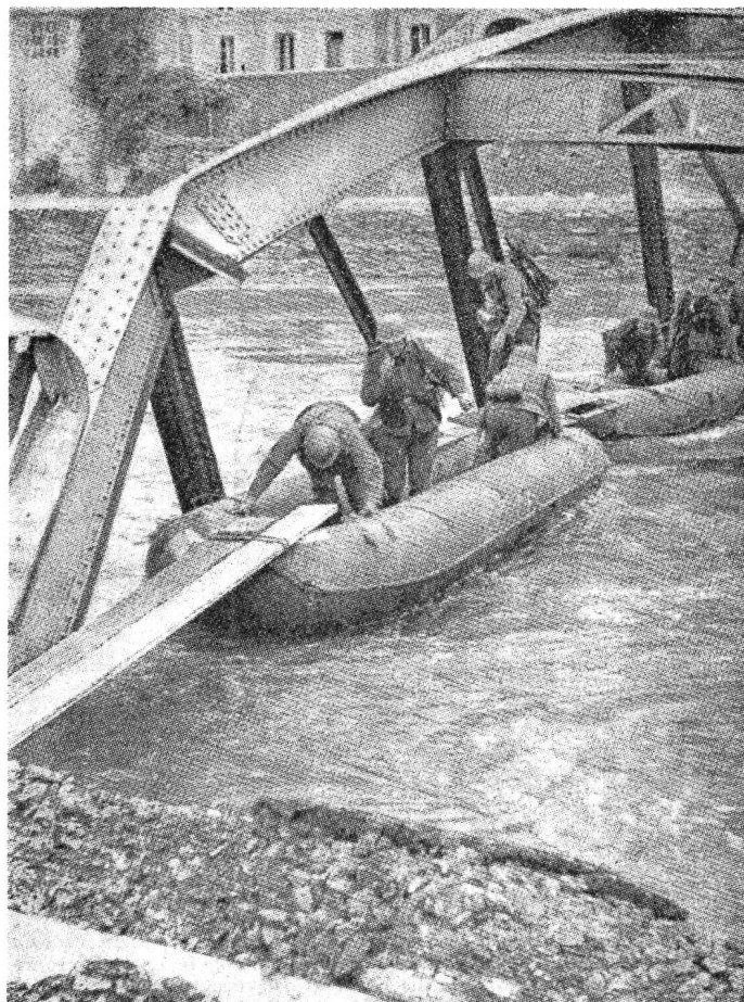
Der Notsteg bei der gesprengten Strassenbrücke Monthermé.
