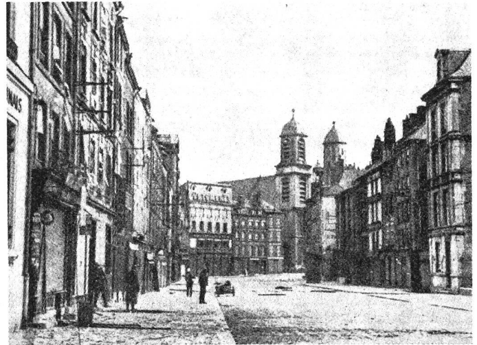
Strassenzug in Sedan. Der auf dem rechten Maasufer gelegene Teil von Sedan war praktisch unverteidigt. Das auf dem linken Maasufer gelegene Quartier Torcy wurde stark umkämpft. Die 13 000 Einwohner waren zu 90 Prozent evakuiert.
