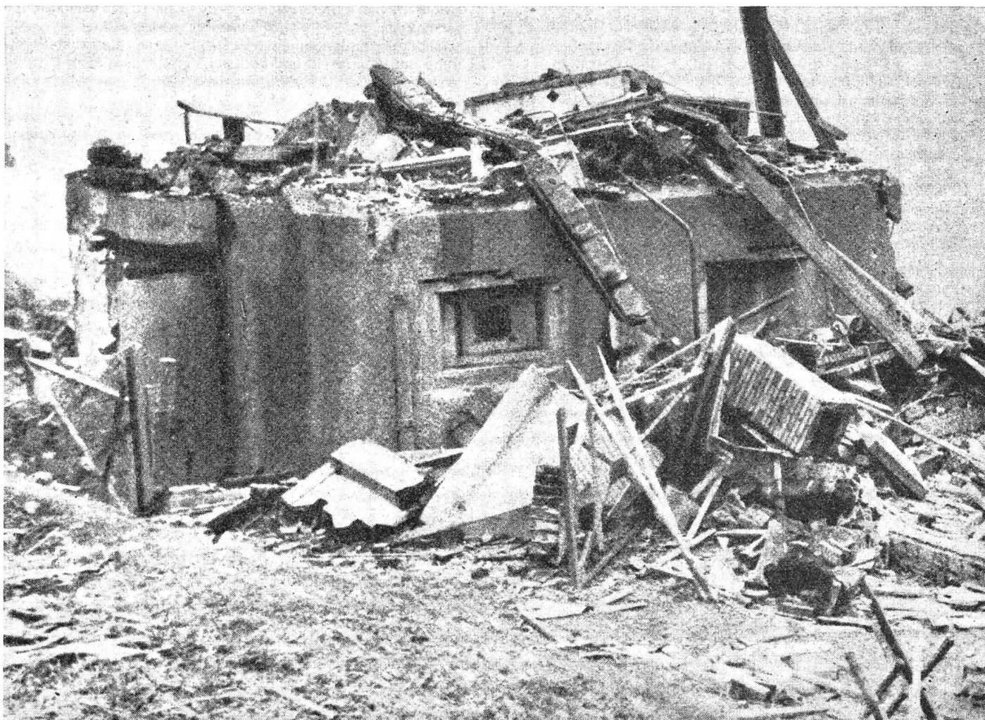
Zerstörter französischer Bunker, Typ «Billotte mittel». Ausbaustärke I: 150 cm Beton. Bewaffung: 1 Pak 2,5 cm + 1 Mg. Links die Mg-Scharte, rechts die Pak-Scharte. Die Trümmer vor den Scharten stammen von der Tarnung her. Die Anlage war als Wohnhaus getarnt.
