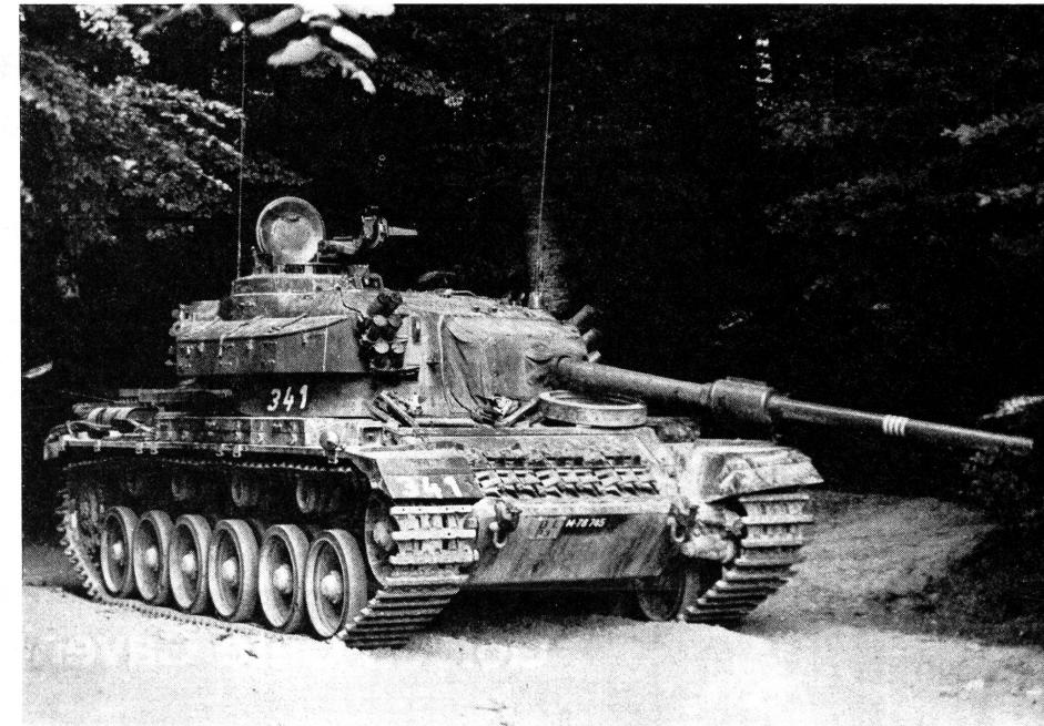
Mit der Kanone kann mittels Stabilisatoreinrichtung auch aus der Bewegung geschossen werden, Schwenkbereich 360 Grad. – Aufnahmen: Fix Zobrist, Hendschiken.
