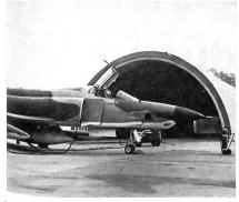
Um am Boden abgestellte Kampfflugzeuge vor der Einwirkung konventioneller Waffen zu schützen, errichtet die USAF gegen-Wärtig in ganz Europa geschützte Flugzeugstandorte. Unser Bild zeigt einen dieser Unterstände, die aus Stahl und Beton gebaut sind. Geplant ist die Errichtung von insgesamt 380 solcher «Shelter». Ein ähnliches Bauprogramm läuft zurzeit auch in unserem Lande. K. A.
