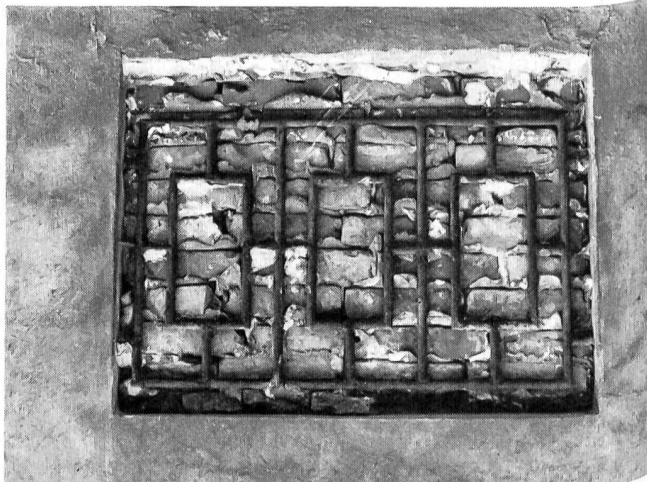
Ein Kellerfenster — zugemauert.
