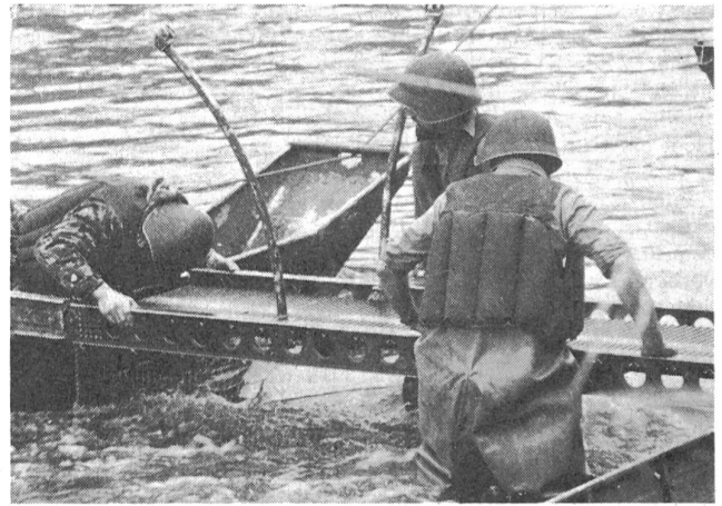
Die Elemente werden rasch zusammengeschoben. Die strengste Arbeit leistet der auf dem Bauche liegende Kopplungsmann.
