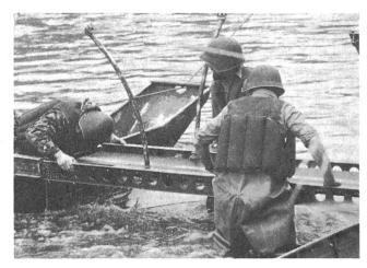
Die Elemente werden rasch zusammengeschoben. Die strengste Arbeit leistet der auf dem Bauche liegende Kopplungsmann.
