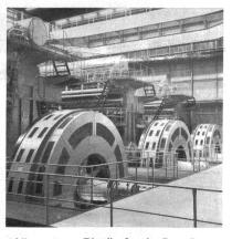
Afrikas grösstes Dieselkraftwerk «Bong Range» in Liberia wird im Endausbau rund 100000 PS Gesamtleistung haben. Die auf dem Bilde gezeigten Sulzermotoren vom Typ 9RF68 entwickeln je 13500 PS Nennleistung.
