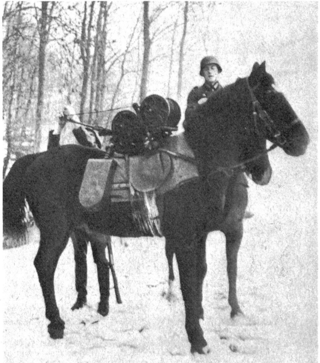
Für den Bau der Telefonleitungen wurden im verschneiten Gebirgs Gelände auch Pferde eingesetzt. Dadurch konnte der Linienbau rascher vorangetrieben werden. Die Kabelrollen sind auf dem Bastsattel des Tragtieres befestigt und werden im Marsch abgespult
