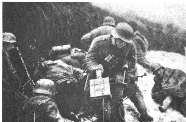
Pionier mit geballter Ladung, bestehend aus 3 Sprengbüchsen à 1 kg
