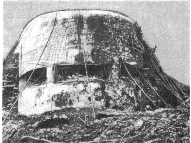
Mg-Bunker des Werkes Rupesko. Das auf einer Höhe von 1828 m gelegene Werk bestand aus drei solchen Bunkern, welche untereinander durch einen Felsenstollen verbunden waren. Feldstellungen ergänzten die permanenten Anlagen. Die Besatzung zählte ca. 350 Mann.
