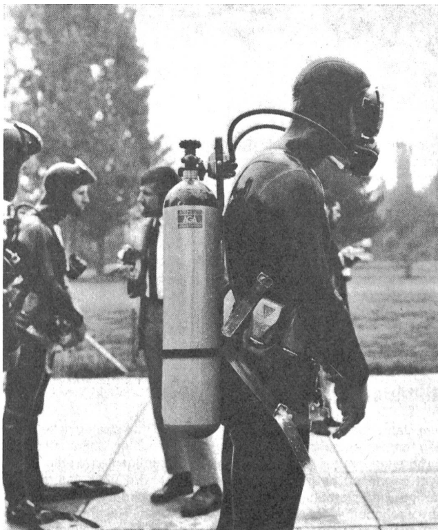
Der gleiche Taucher wie auf Bild 1, diesmal von der Seite. Beim mitgetragenen Atemgerät handelt es sich um ein Pressluftgerät. Deutlich sichtbar die am Gürtel mitgeführten Bleigewichte, die das Verbleiben unter Wasser erleichtern.
