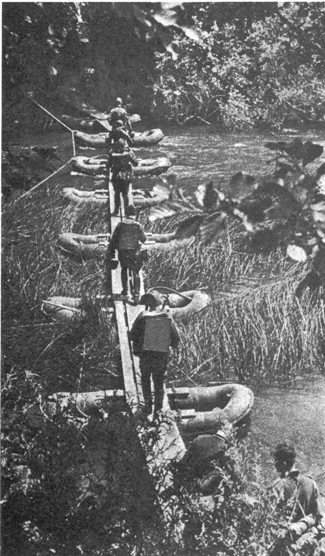
Zahlreiche Bachläufe, Stichkanäle und Altwasser schaffen für den Angreifer zusätzliche Hindernisse. Er ist dadurch gezwungen, ein Mehrfaches an Übersetzmitteln einzusetzen. Im Bild: Schlauchbootsteg für Fussgruppen über die Steingriengiesen.
