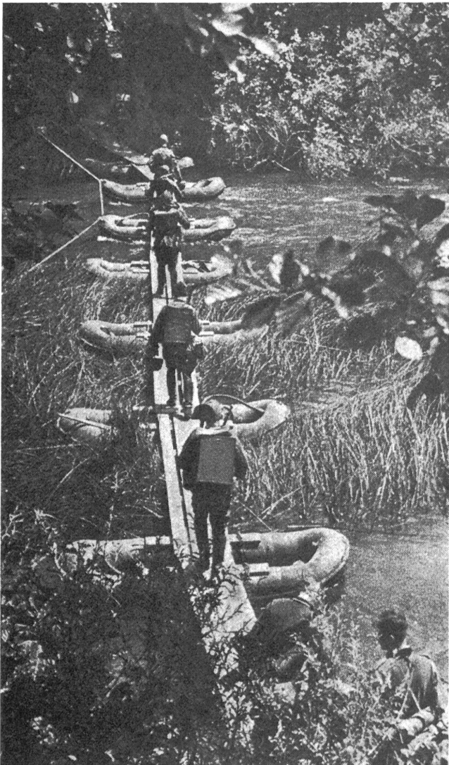
Zahlreiche Bachläufe, Stichkanäle und Altwasser schaffen für den Angreifer zusätzliche Hindernisse. Er ist dadurch gezwungen, ein Mehrfaches an Übersetzmitteln einzusetzen. Im Bild: Schlauchbootsteg für Fusstruppen über die Steingriengissen.
