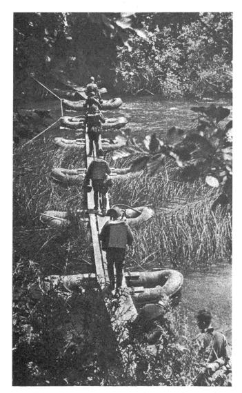
Zahlreiche Bachläufe, Stichkanäle und Altwasser schaffen für den Angreifer zusätzliche Hindernisse. Er ist dadurch gezwungen, ein Mehrfaches an Übersetzmitteln einzusetzen. Im Bild: Schlauchbootsteg für Fusstruppen über die Steingriengiessen.
