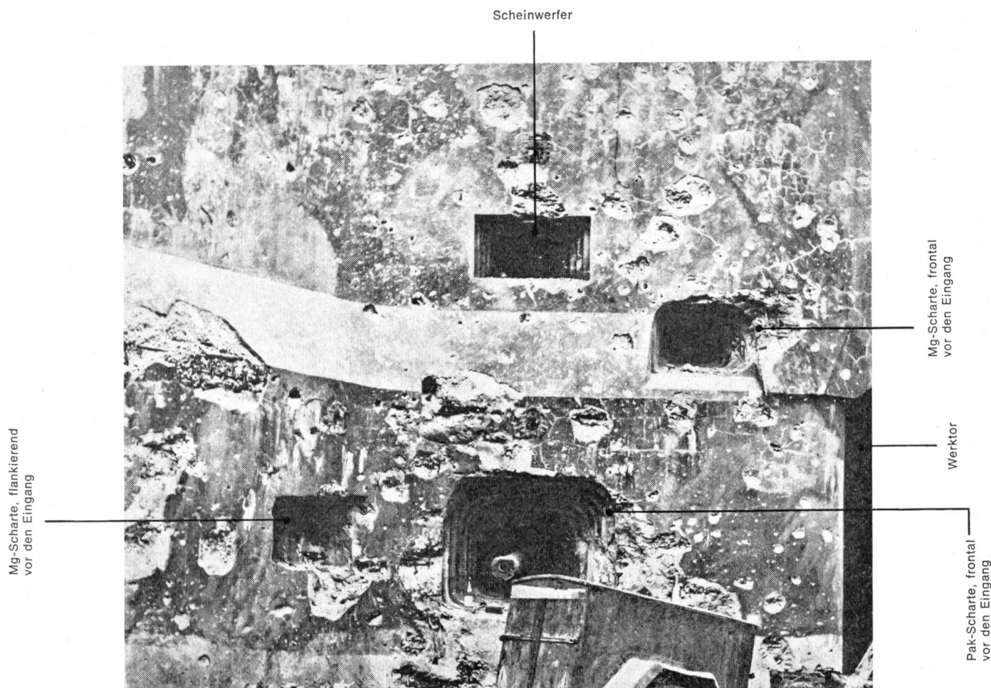
Haupteingang zum Artilleriewerk Eben Emael. Nahaufnahme von Objekt 14, «Scharten der Eingangsverteidigung». Die Beschädigungen an der Betonwand rühren her:
