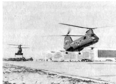
Bei einem Versorgungsdienst für einen Flugzeugträger befördern die «Sea Knights» 200 bis 300 vorgepackte Lasten von je 1575 kg Gewicht, die auf dem rückwärtigen Flugdeck laufend gestapelt werden und von den Helikoptern mit je einer Minute Abstand aufgenommen und zu dem übernehmenden Schiff geflogen werden. Tic
