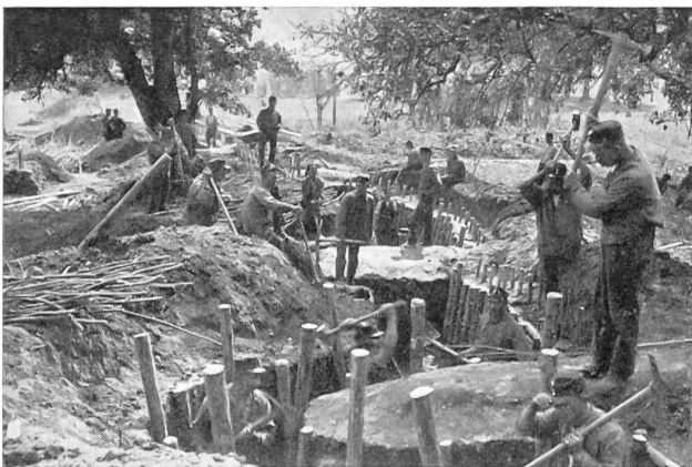
Schützengrabensbau im Fortifikationsgebiet Hauenstein. Das ganze Hauensteingebiet wurde mäßig befestigt als Abwehrstellung gegen einen Angreifer von Norden her, besonders im Hinblick auf den wichtigen Eisenbahnknotenpunkt Olten. Zum Schutze vor Sprengwirkungen des feindlichen Artilleriefeuers und Handgranatenangriffen wurden die Lauf- und Schützengräben nicht gradlinig, sondern möglichst gewunden angelegt.
