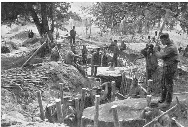
Schützengrabenbau im Fortifikationsgebiet Hauenstein. Das ganze Hauensteingebiet wurde mäßig befestigt als Abwehrstellung gegen einen Angreifer von Norden her, besonders im Hinblick auf den wichtigen Eisenbahnknotenpunkt Olten. Zum Schutze vor Sprengwirkungen des feindlichen Artilleriefeuers und Handgranatenangriffen wurden die Lauf- und Schützengräben nicht gradlinig, sondern möglichst gewunden angelegt.
