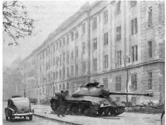
Das Hauptportal der Kilian Kaserne nach dem Sieg der Revolution (31. Oktober 1956). Im Vordergrund ein vernichteter russischer Panzer. (Aufnahme des Verfassers)
